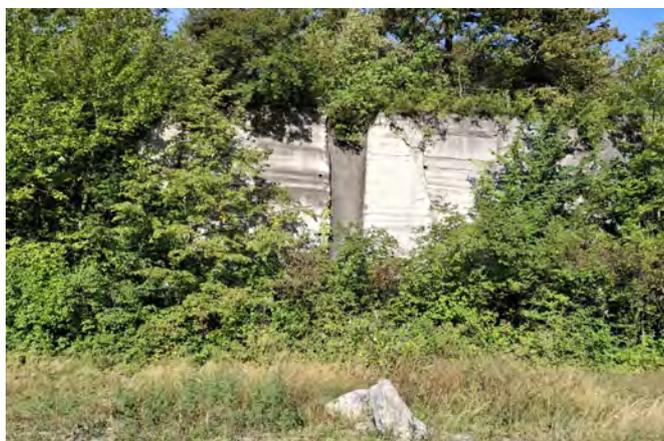
Traces de l'exploitation du calcaire par la technique du fil (G. Borel - MCG, 2024)
