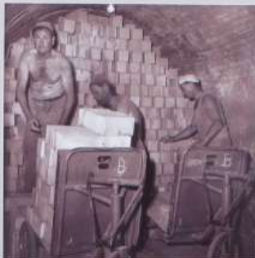
Carico del forno nella fornace di Balerna (Archivio ITL)
