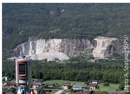
La carrière de Lodrino est l'un des sites inventoriés dans le cadre du projet Via della Pietra.
